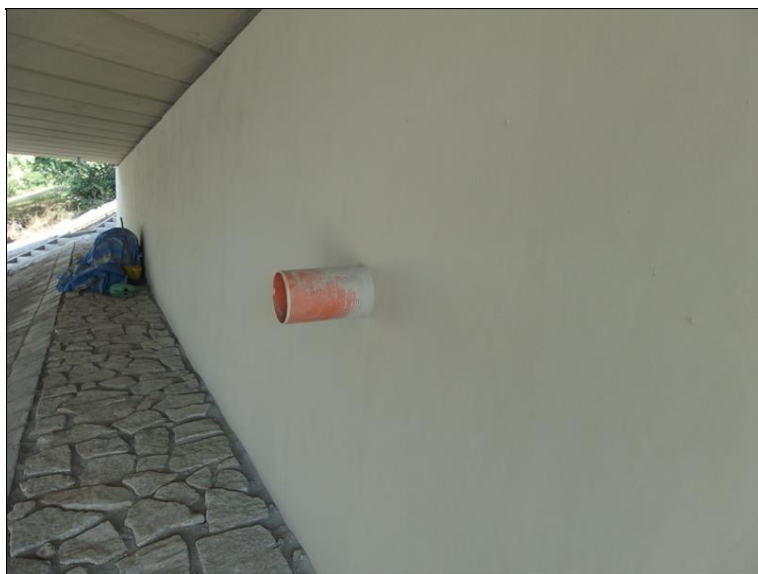
ODVODNĚNÍ OPĚR1
