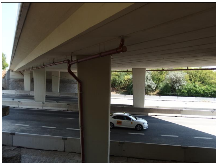
SVOD ODVODNĚNÍ MOSTU
