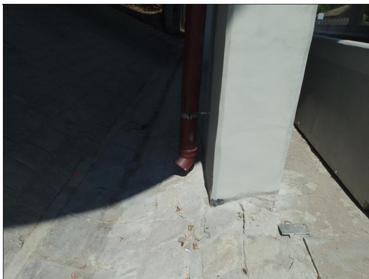
SVOD ODVODNĚNÍ MOSTU
