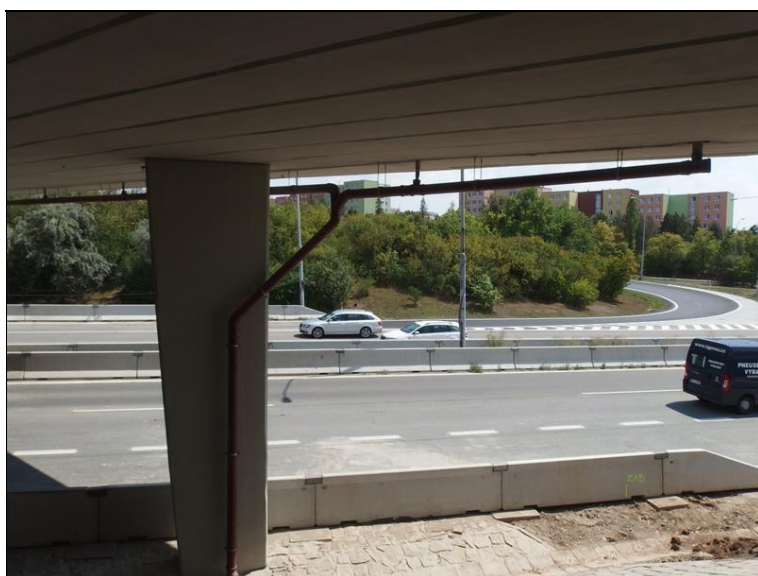
ODVODNĚNÍ MOSTU
