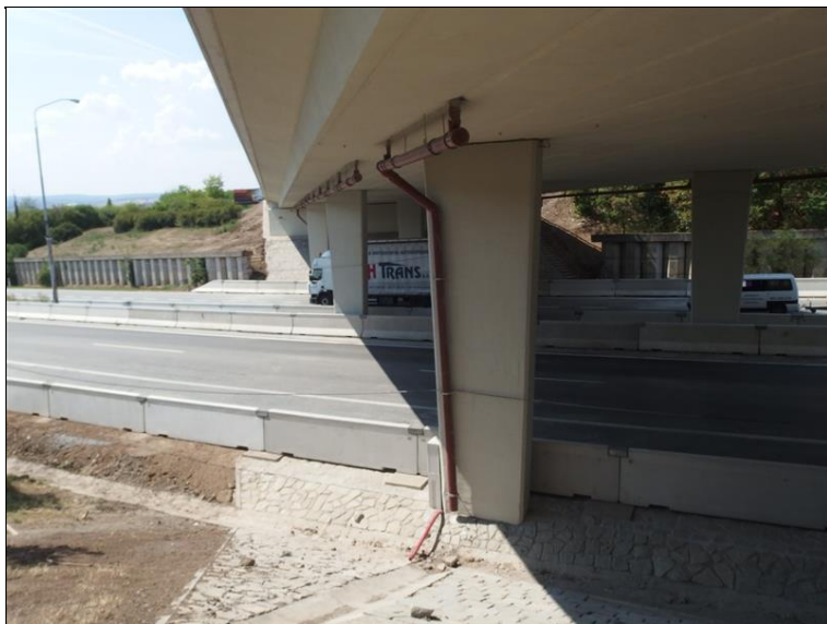
SVOD ODVODNĚNÍ MOSTU
